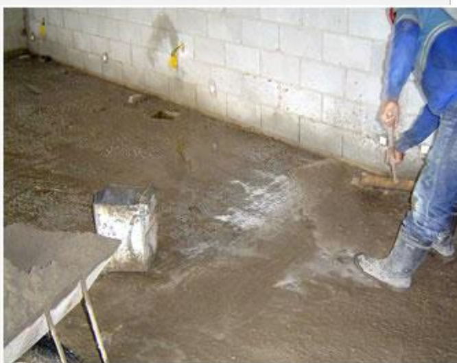
Aplicação da ponte de aderência
